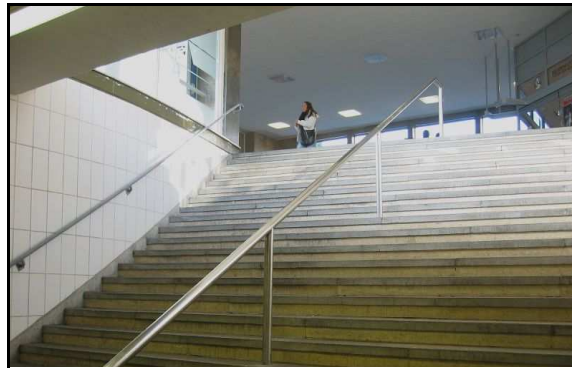
Bahnhof HDH für Rollstühle, für Behinderte, für ältere Personen völlig ungeeignet. Ein Bahnhof ohne Gepäckband und Aufzug. Der Heidenheimer-Bahn-Skandal!
